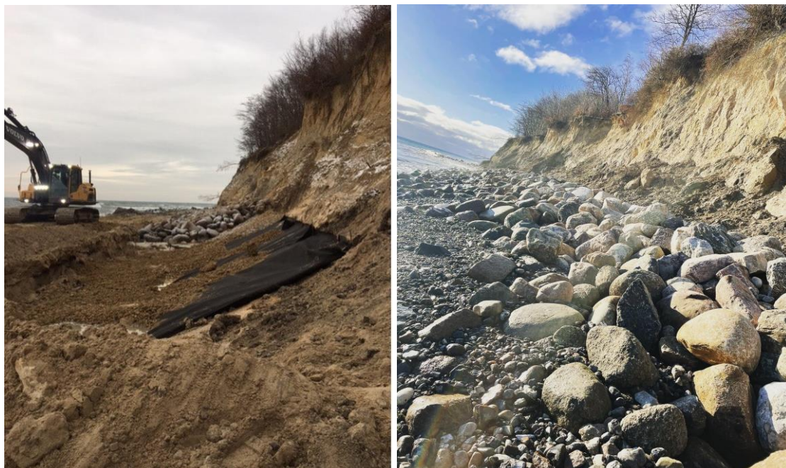
Opbygning af skræntfodssikring vinter 2022 Pomle Nakke.
